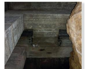
partielle Betonabplatzungen; freiliegende, korrodierte Bewehrung; Feuchtstellen; Risse; Straßenabläufe beschädigt
