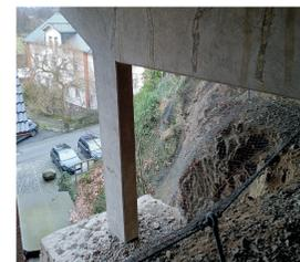
partielle Betonabplatzungen und freiliegende, korrodierte Bewehrung
